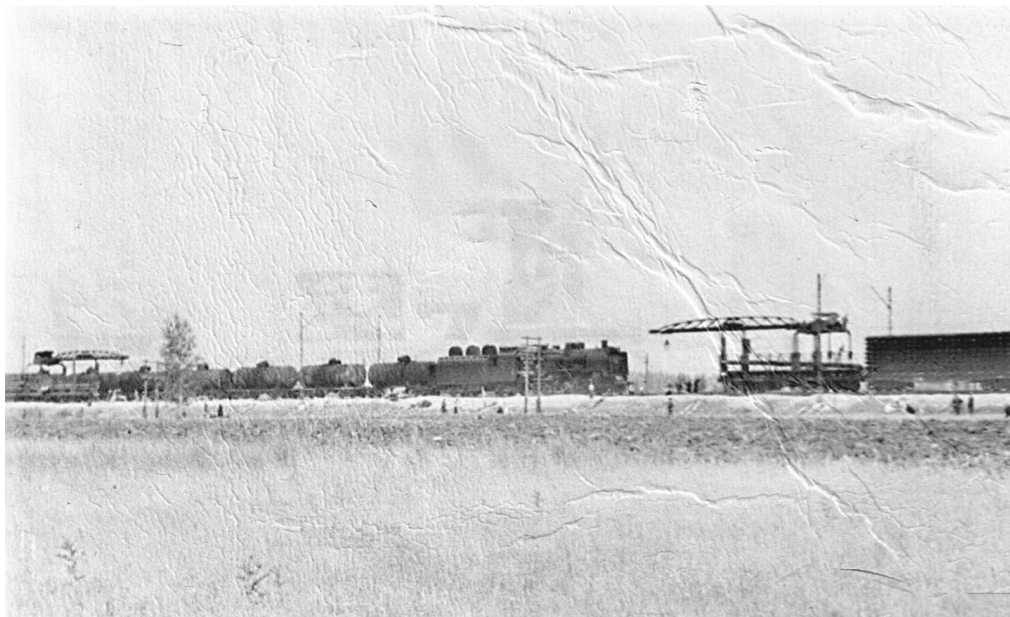
Рис. 3. Паровоз серии СО19. Идут работы по реконструкции четного пути на перегоне Кормиловка — Калачинская бывшей Омской ж. д., июль 1954 г. [7]
